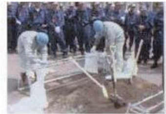
図 2-1 器具に土嚢袋をセットする
