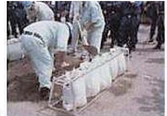
図 2-2 充填物をシャベル等で詰め込む
