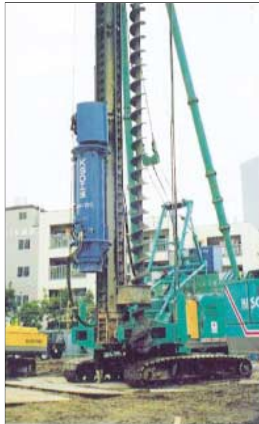
KSD工法で作業中の工事現場
