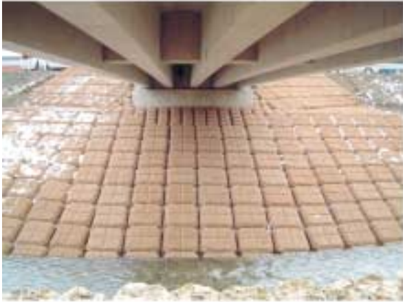
植生ブロック工事中
